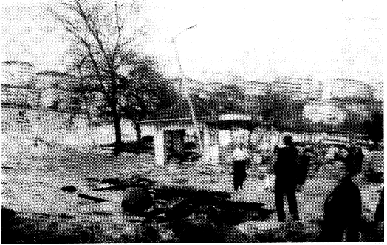
Değirmendere'de dolgu zeminlerde deprem sonrası görünüm (Foi®: H.Ü. Çakşım Grubu arşivinden)
